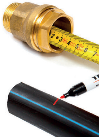
2 Mittaa liittimen sisään menevän putken pituus ja merkitse se putkeen.
